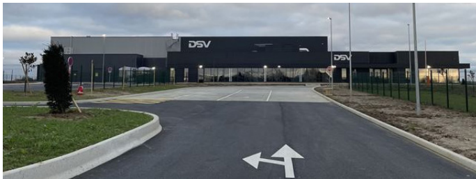
Locaux de la société DSV
